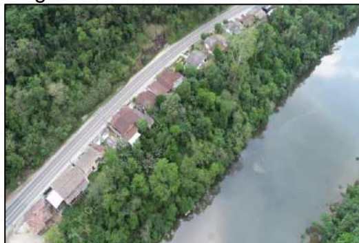
Figura 237 - Residências em APP
