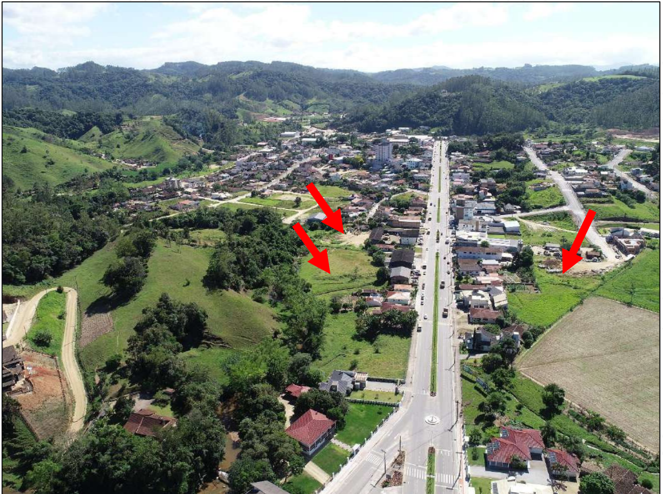
Figura 52 – Registro Realizado Através do Equipamento VANT da Reambulação do Ponto 6 e Ponto 7 Montante e Jusante do Curso Hídrico a qual foi canalizado e passa através de tubulação por baixo da AV. Sete de Setembro
