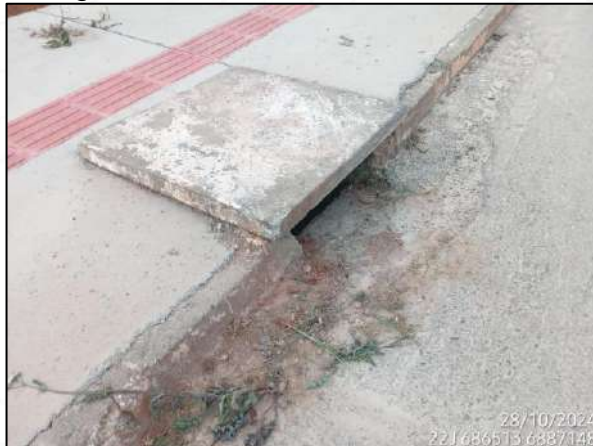
Figura 110 - Boca de Lobo de Guia
