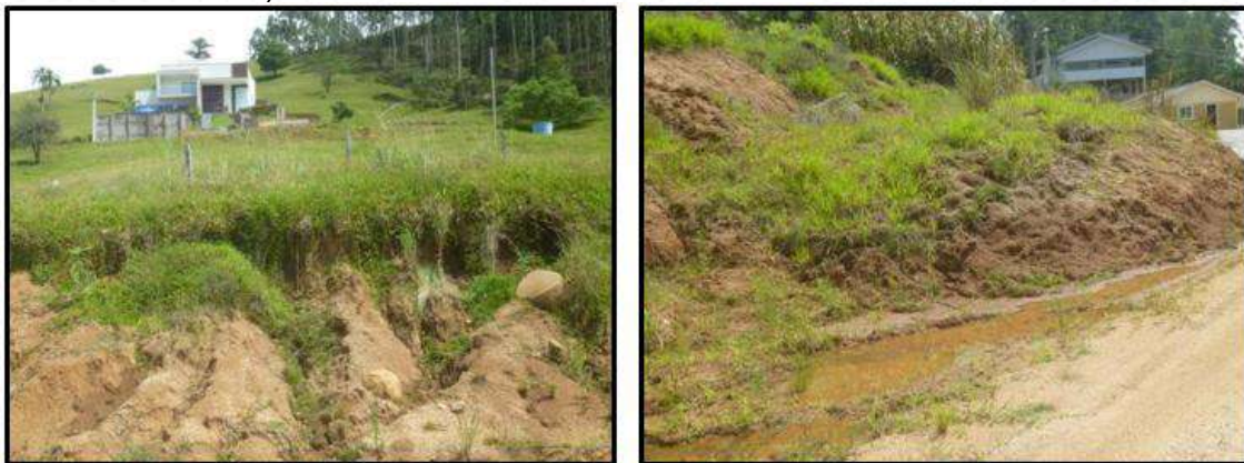
Figura 18 - Deslizamento ativo em deposito coluvial sobre diabásio no perímetro urbano atual. Margem direita do Rio Braço do Norte (ref. Coord. UTM 684612/6885897).
