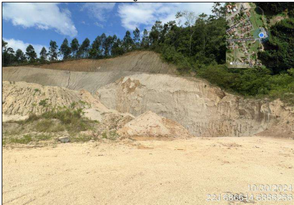
Figura 21 – Detalhe dos cortes realizados nesta área onde aflora solos derivados do granito, na qual são utilizados como jazidas de saibro, onde o solo nesta região é mais arenoso.
