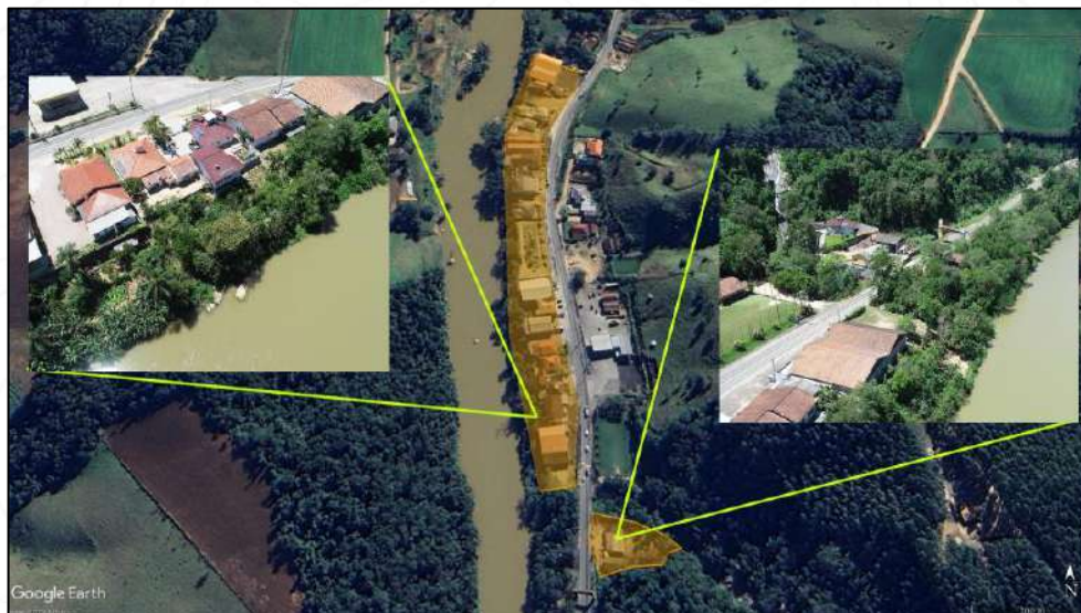
Figura 242 – Registro de residências dentro de área de risco ambiental para enxurradas/inundações em APP e deslizamento planar de solo em encosta de morro.
