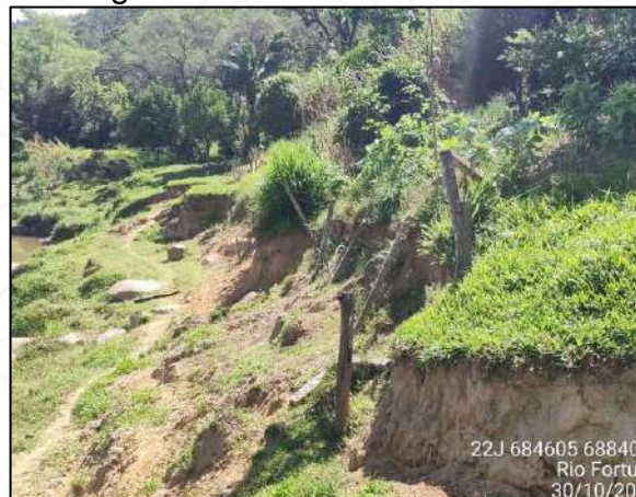
Figura 183 - Erosão em talude
