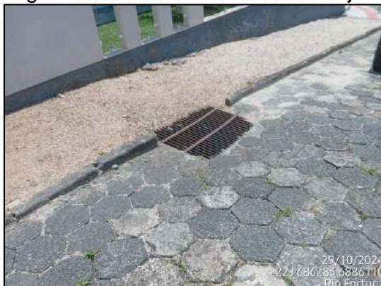
Figura 117 - Boca de Lobo de Sarjeta
