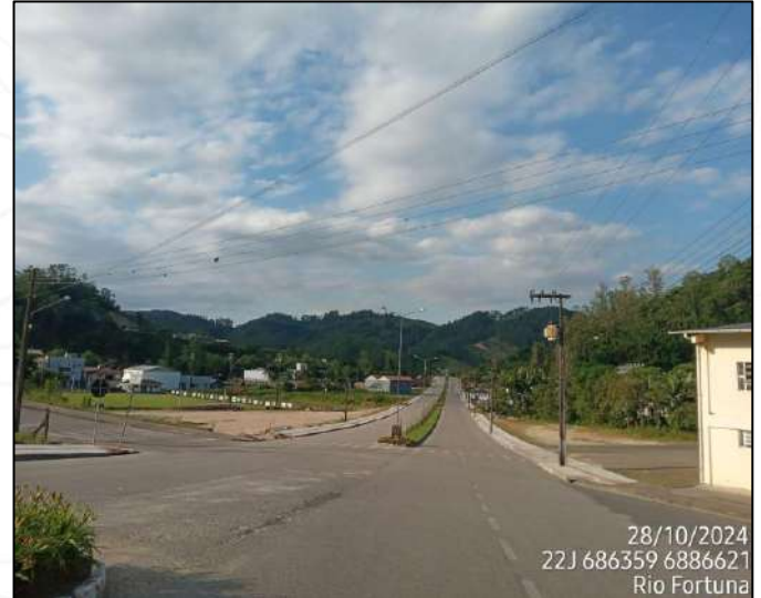
Figura 102 - Vias Pavimentadas na Avenida Sete de Setembro
