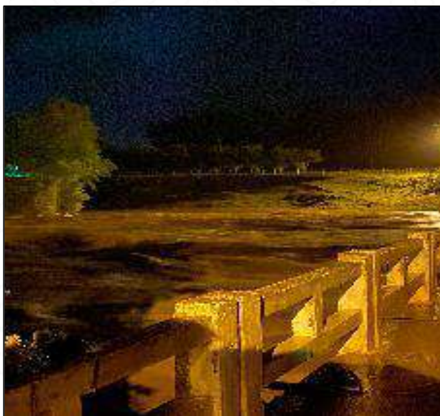
Figura 254 – Imagem de enxurrada sobre a Ponte Gustavo Kuhen.
