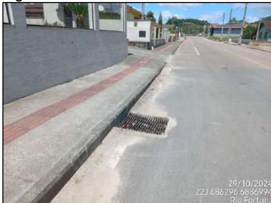
Figura 115 - Boca de Lobo de Guia
