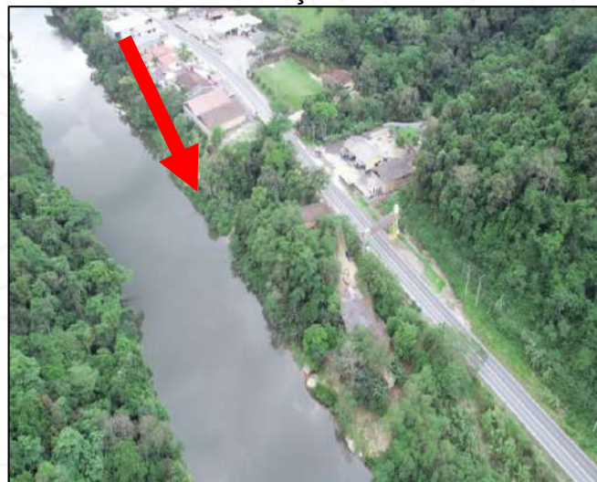
Figura 62 - Reambulação do Ponto 10 Jusante e Vista Geral do Ponto de Deságue no Rio Braço do Norte
