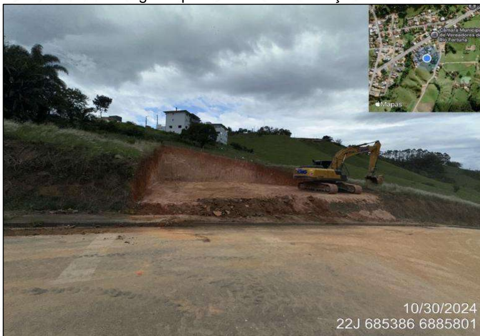
Figura 35 – Talude de corte onde aflora um solo podzólico vermelho-amarelo. Local este situado na base da encosta, abaixo do mirante. Nota-se a inclinação acentuada final dos taludes, torna-se um fator de risco e exige algum tipo de muro de contenção.
