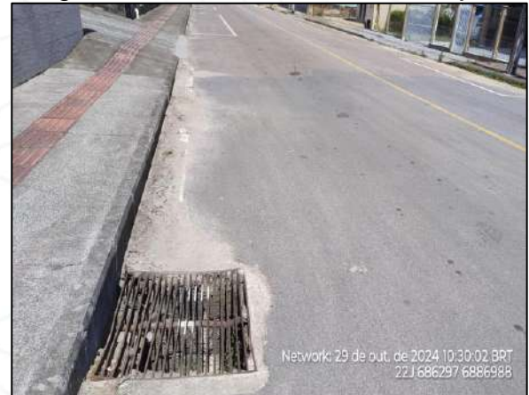
Figura 111 - Boca de Lobo de Sarjeta
