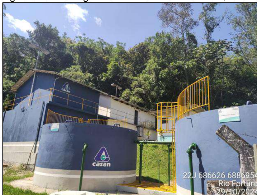
Figura 123 - Vista geral dos reservatórios R1 e R2, na ETA
