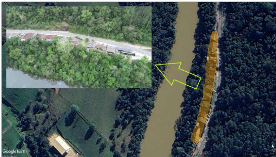
Figura 240 - Imagem ilustrando porção da comunidade ribeirinha Nossa Senhora de Lourdes, situada em área de risco de enxurrada/inundação.
