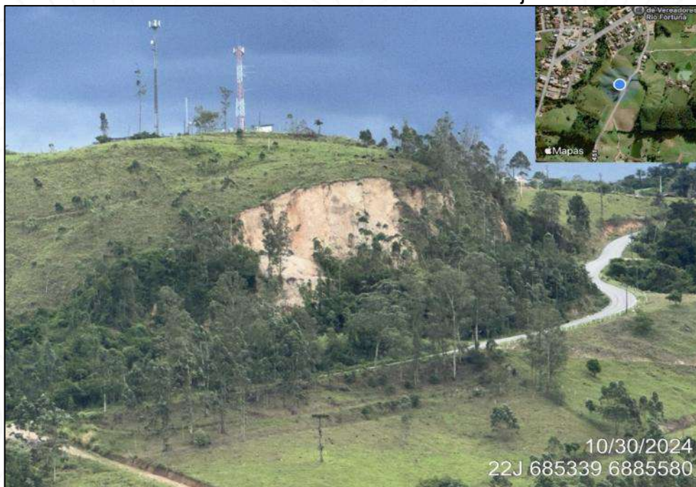
Figura 34 – Afloramento caracterizado com solo do tipo Cambissolo, próximo ao morro das antenas. Local este utilizado como jazida de saibro.
