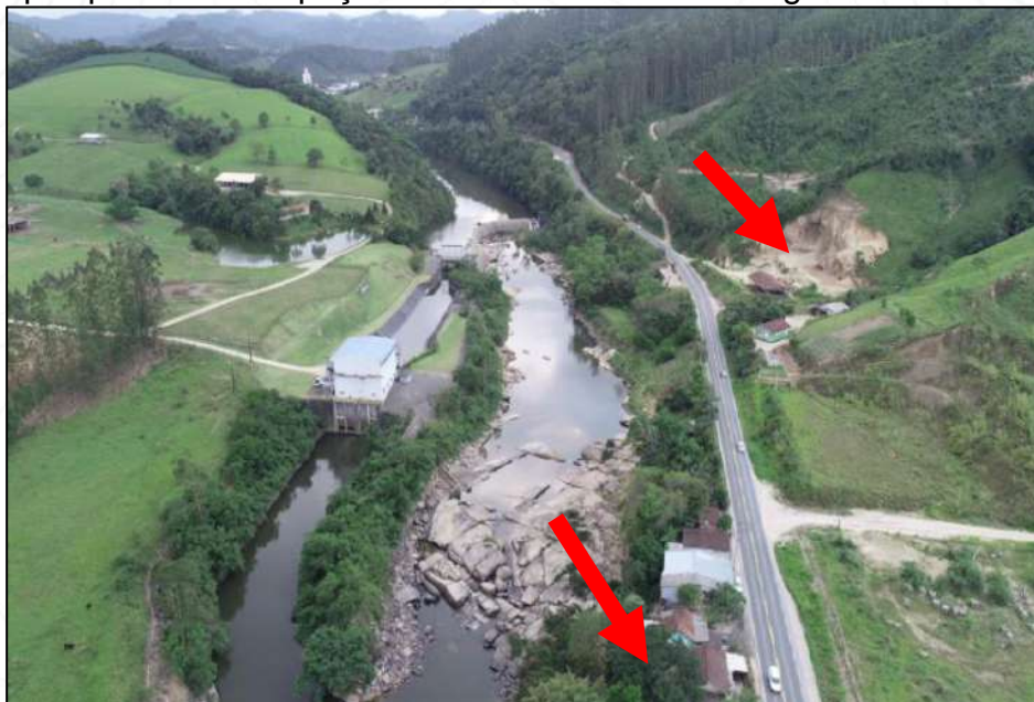
Figura 73 - Registro Realizado Através do Equipamento VANT da Reambulação do Ponto 16, a qual possuem ocupação em APP e área com Fragilidade Ambiental
