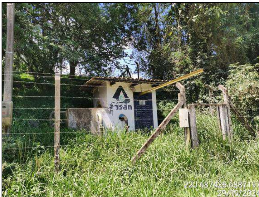
Figura 122 - Estrutura que comporta a ERAB 01, às margens da rodovia SC-436
