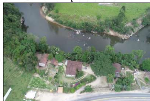
Figura 232 - Residências em APP do Rio Braço do Norte
