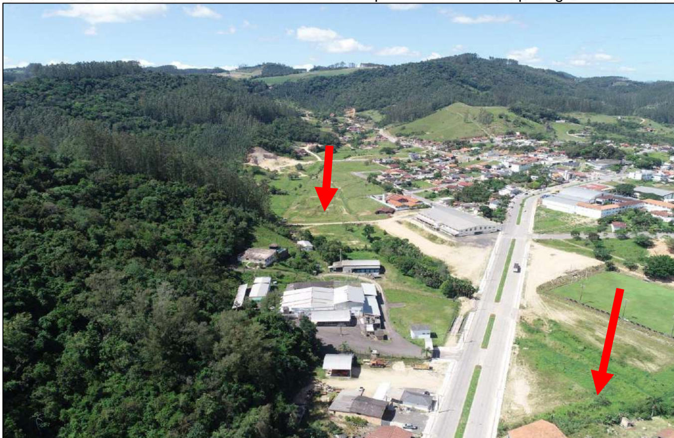
Figura 65 - Registro Realizado Através do Equipamento VANT da Reambulação do Ponto 12 Montante e Jusante do Curso Hídrico a qual encontra-se desprotegido
