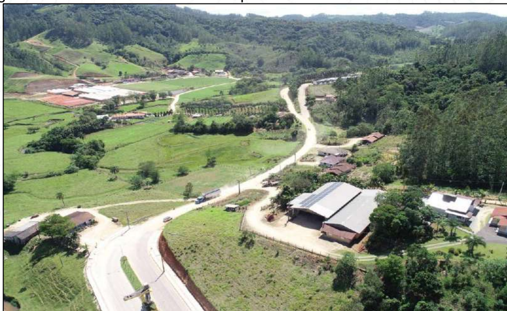
Figura 105 - Conexão entre avenida pavimentada e trecho de estrada de chão
