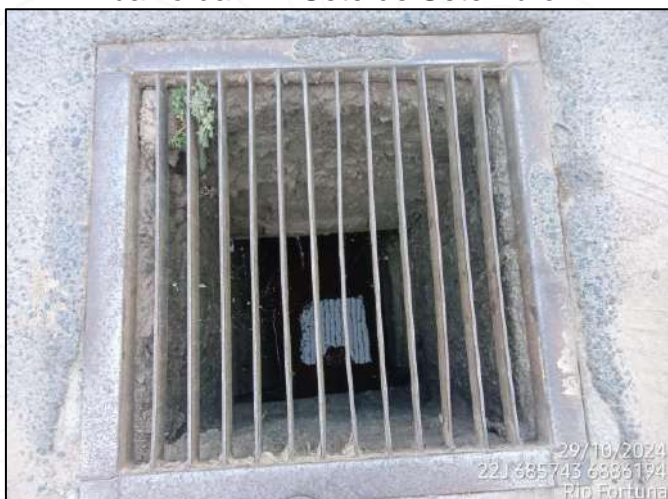
Figura 50 - Reambulação do Ponto 6 Montante do Curso Hídrico a qual foi canalizado e passa através de tubulação por baixo da AV. Sete de Setembro
