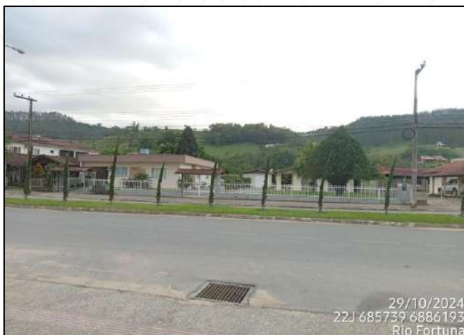
Figura 48 - Reambulação do Ponto 6 Montante do Curso Hídrico a qual foi canalizado e passa através de tubulação por baixo da AV. Sete de Setembro
