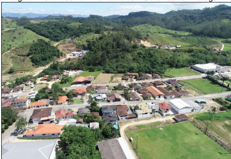
Figura 120 - Ruas Pavimentadas com Sistemas de Drenagem
