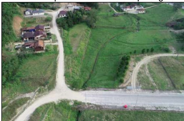
Figura 66 - Registro Realizado Através do Equipamento VANT da Reambulação do Ponto 12 Montante e Jusante do Curso Hídrico a qual encontra-se desprotegido
