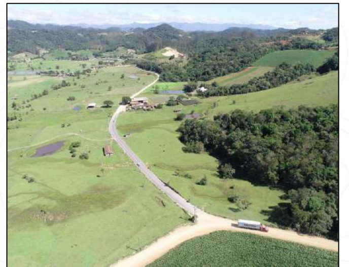
Figura 104 - Trecho de conexão entre via asfaltada e estrada de terra
