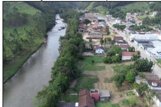
Figura 234 - Residências em APP no Rio Braço do Norte na parte central
