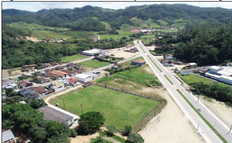
Figura 119 - Avenida com Pavimentação e Sistema de Drenagem
