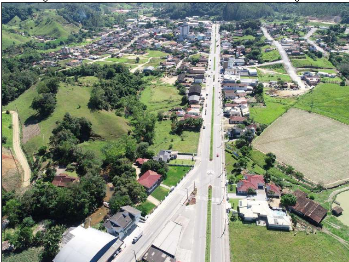
Figura 109 - Avenida Pavimentada com Sistema de Drenagem
