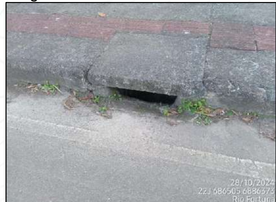
Figura 116 - Boca de Lobo de Guia
