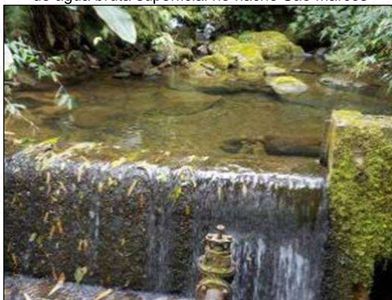
Figura 121 - Adutora de água bruta e estrutura da barragem para captação de água bruta superficial no riacho São Marcos
