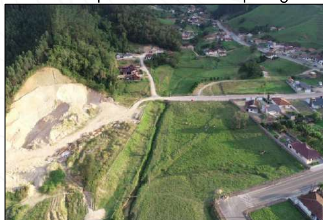
Figura 67 - Registro Realizado Através do Equipamento VANT da Reambulação do Ponto 12 Montante e Jusante do Curso Hídrico a qual encontra-se desprotegido
