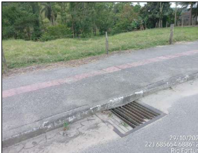
Figura 53 - Reambulação do Ponto 7 Montante do Curso Hídrico a qual foi canalizado e passa através de tubulação por baixo da AV. Sete de Setembro
