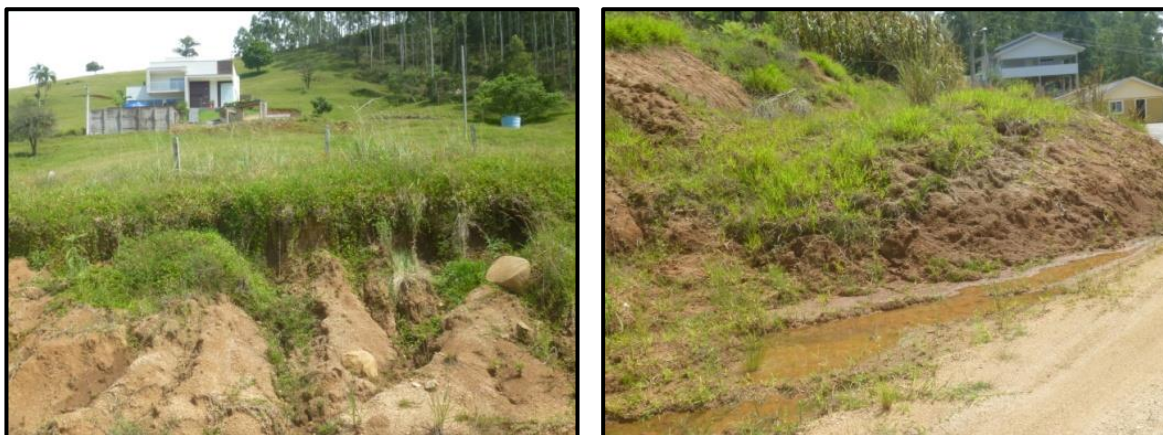
Figura 14. Deslizamento ativo em depósito colúvio sobre diabásio no perímetro urbano atual. Margem direita do Rio Braço do Norte (ref. Coord. UTM 684612/6885897).
